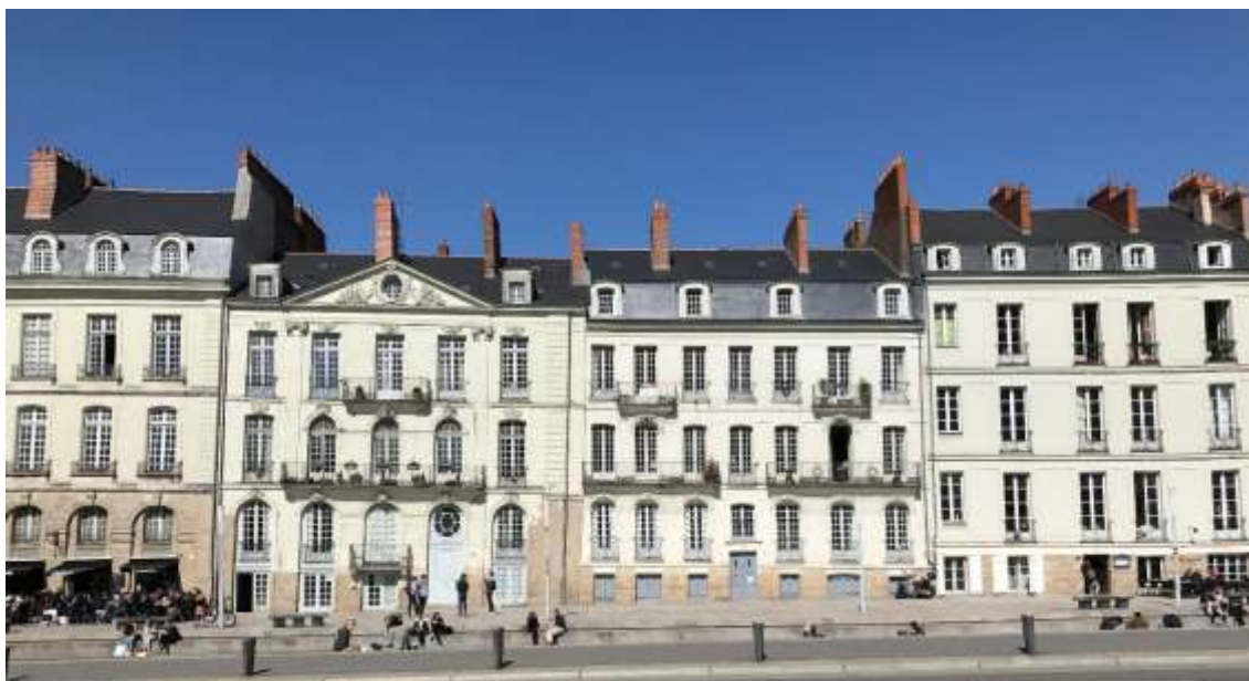
L'immeuble Perraudau 1752 avec un fronton triangulaire néo-classique, 13, quai Turenne, Nantes, Photo: C. Mansfield 6 avril 2017.
